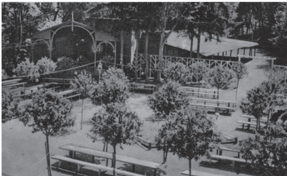
Stara Grabina - muszla koncertowa i budynek restauracji Johanna Buchholza za składem piwnicznym piwa. Arch.: Grzegorz Myk z Koronowa
