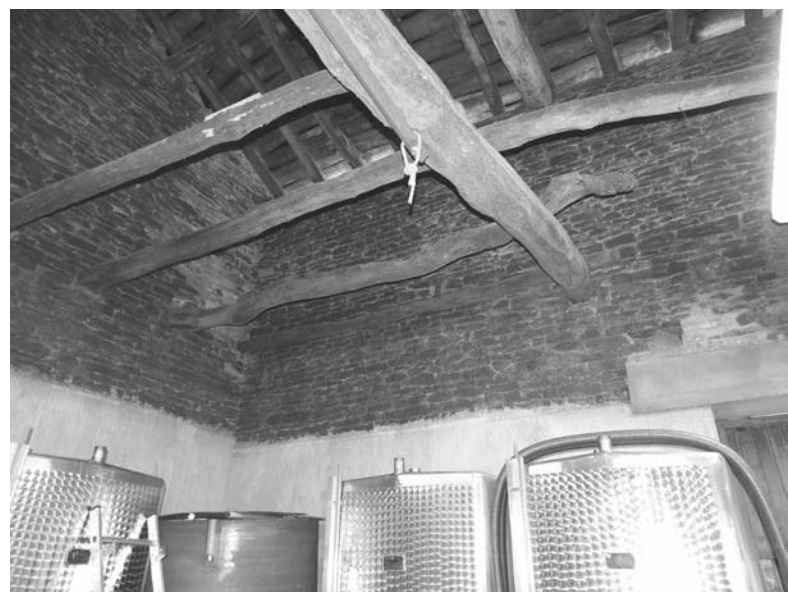
Tradycja i nowoczesność w gospodarstwie winiarskim Lionela Marin – kadzie fermentacyjne z nierdzewnej stali w tłoczni zbudowanej przed dwustu laty, w której zachowały się oryginalne kamienne mury i stara więźba. La tradition et la modernité dans la vigne de Lionel Marin – les cuves de fermentation en acier inoxydable dans la salle de traitement construite il y a 12 ans dans laquelle on a conservé les murs originaux en pierre et la vieille charpente
